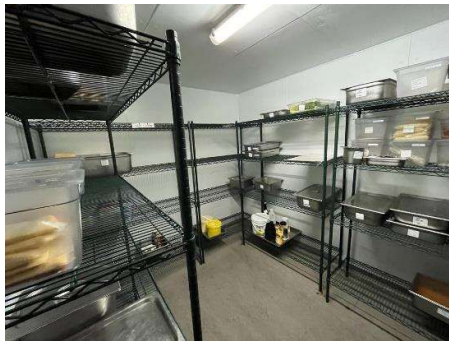
Figure 3. 22 Mise en Place Chiller
